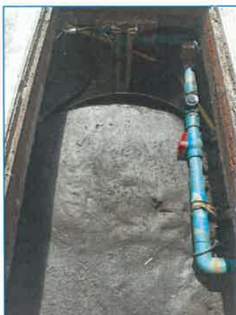
ภาพถ่ายที่ 2.2-17 การดูตากตะกอนจากระบบบำบัดน้ำเสีย
