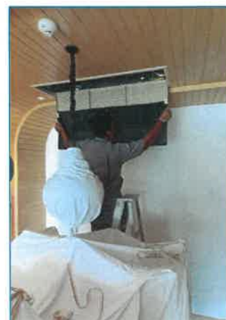
ภาพถ่ายที่ 2.2-31 การทำความสะอาดระบบปรับอากาศและระบบระบายอากาศ
