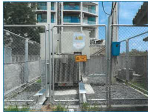
ภาพถ่ายที่ 2.2-21 หม้อแปลงไฟฟ้าพร้อมป้ายเตือน
